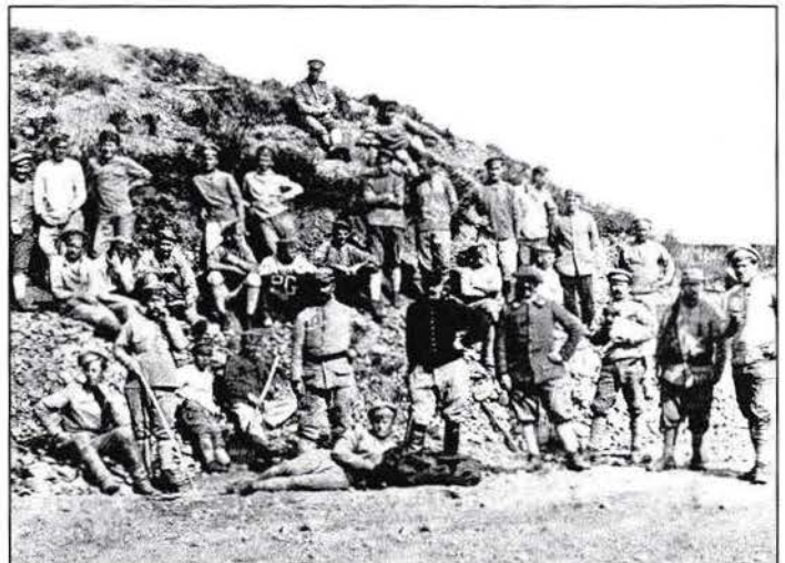
Un chantier avec encadrement français
