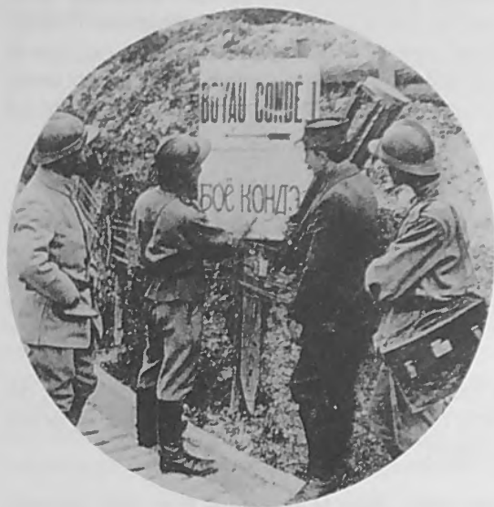
Pose de pancartes dans les tranchées
