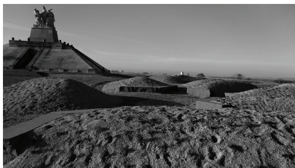
Travaux en cours sur l'aménagement du « Jardin de la Paix »
