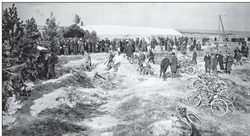
4 novembre 1923 : Pose de la première pierre
