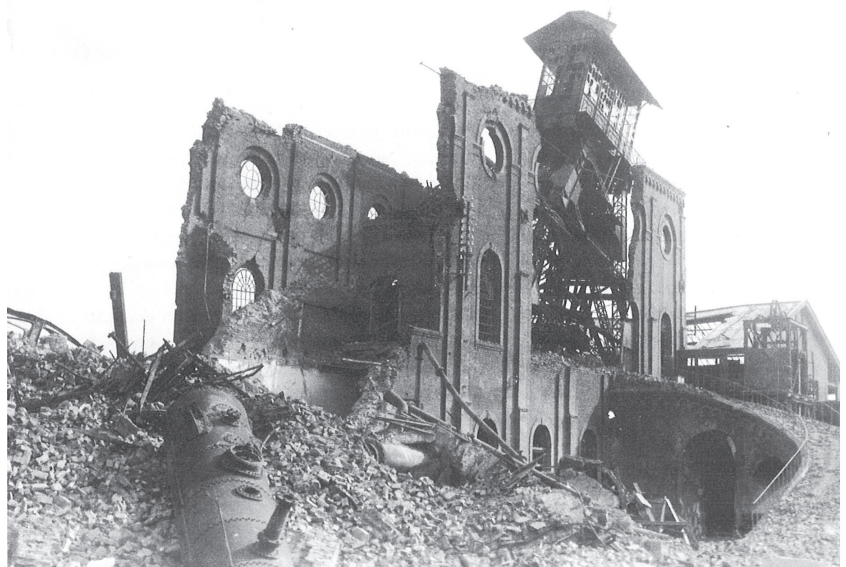
Les restes d'une mine dynamitée.
