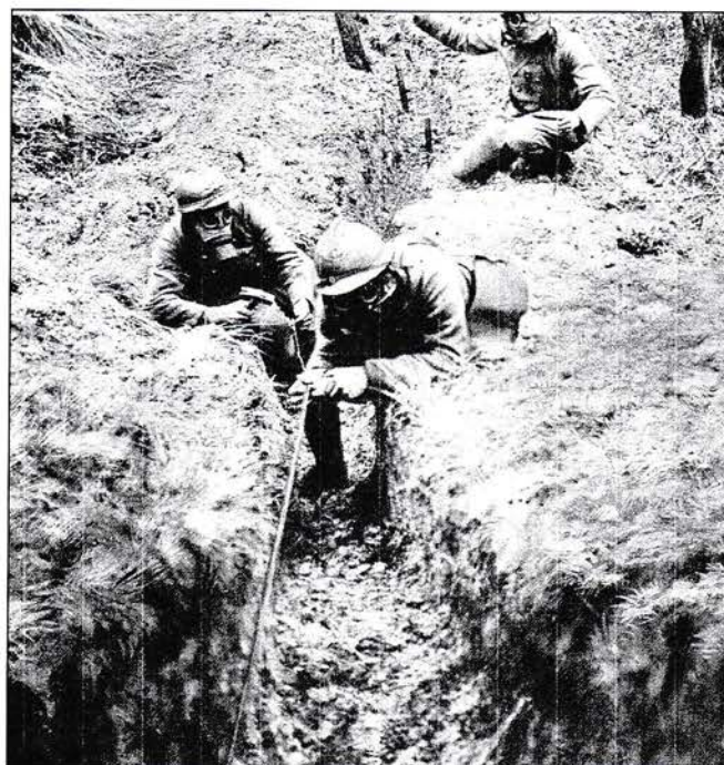
Enfouissement des lignes téléphoniques en zone contaminée par les gaz.
