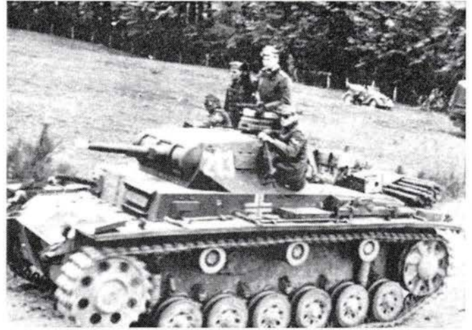
Char moyen Panzer III armé d'un canon de 37 équipage 5 hommes
